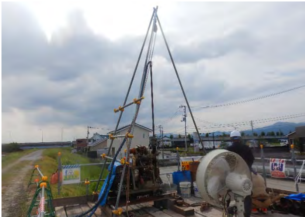
写真1：空気注入箇所のボーリング削孔状況
