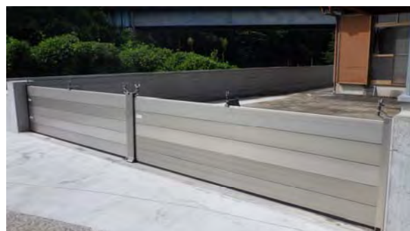
止水壁工事による浸水対策を実施した住家
