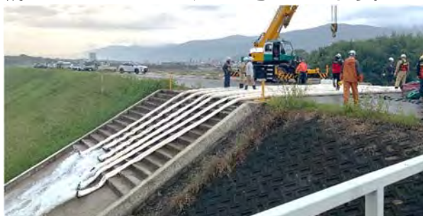
美馬市主催の排水ポンプ車訓練の様子
