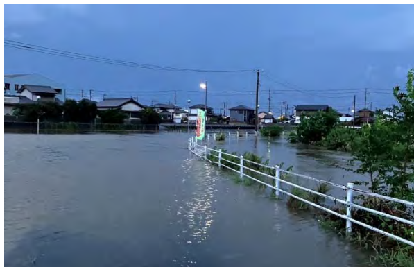
令和6年8月の線状降水帯により道路が冠水した様子
