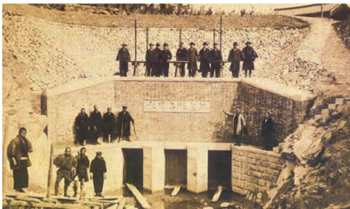
【写真4】完成した取水口（明治末・川島町）
