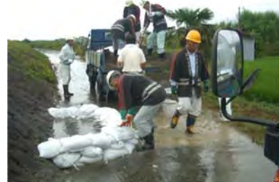
水防団による水防活動 (月輪工法)
