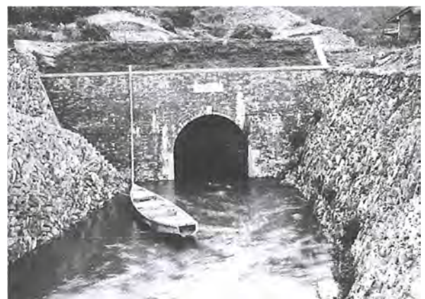
【写真5】川島の古城下を掘りぬいた取水口の出口
