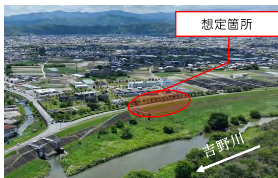
堤防決壊想定箇所
