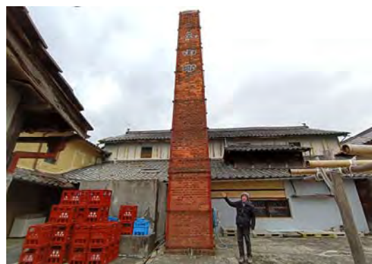
酒造所に残る明治時代から大正時代末期の古い建物のうち、事務所・酒造蔵・仕込蔵・杜氏宿舎・煙突が2019年12月に国登録有形文化財（建造物）に登録されています。
