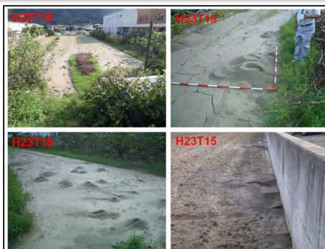
図1.平成23号台風15号における川島箇所の漏水被害の状況
