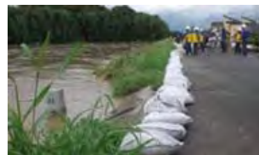
積み土のう工など 水防工法の実施
