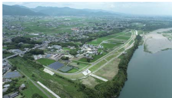
伊沢市堤防完成状況。本格的な治水事業が始まった1885年から136年の年月を経て吉野川下流の築堤工事が完了しました。
