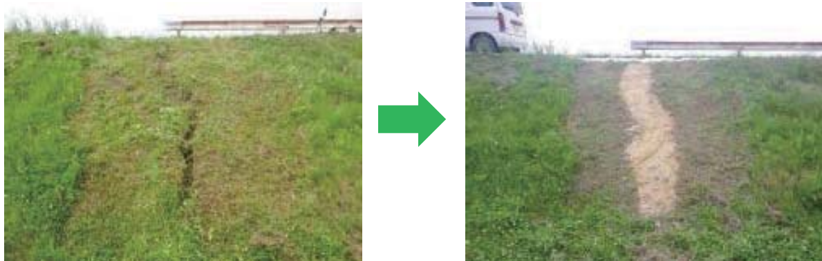
写真5.堤防法面補修の事例
