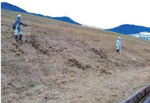
写真3.堤防点検の様子
