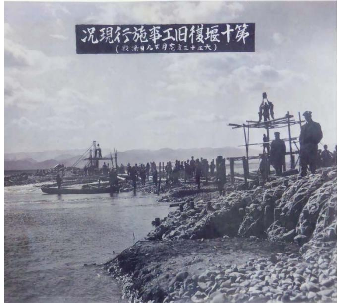
写真 6. 第十堰復旧工事（大正 13 年）
