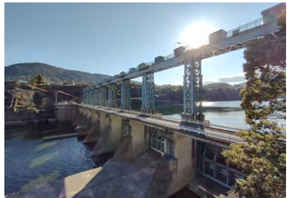
池田ダムは堤高24mで堤長247mの重力式コンクリートダムです。ダムから放流される水を利用して四国電力（株）が最大5000kwの発電も行っています。
