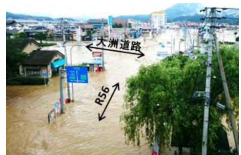
写真 1. 愛媛県大洲市の浸水状況
