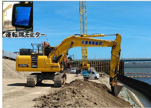
② ICT法面整形
