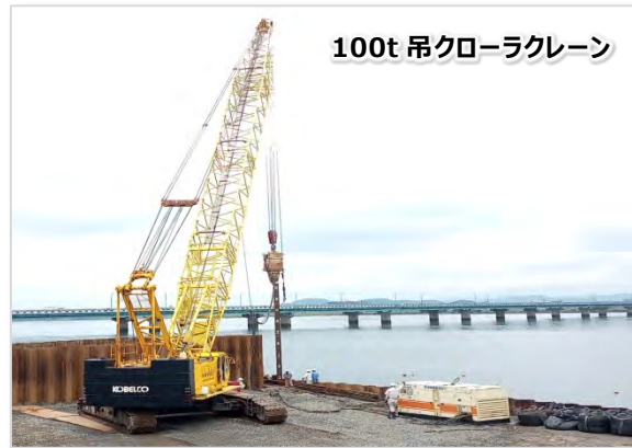
④ 広幅鋼矢板打設
