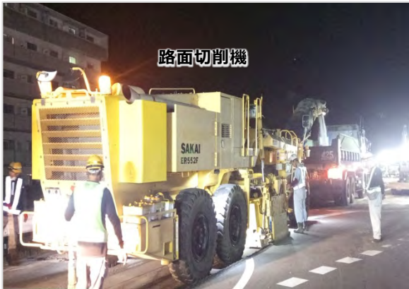
③ 県道迂回路（夜間施工）
