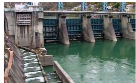
池田ダムに併設されている魚道施設(写真左下)。昨年4月から8月末にかけて約22万匹（推定値）の鮎が遡上しました。写真は池田総合管理所ウェブサイト『画像情報』よりダウンロードしたものです。
