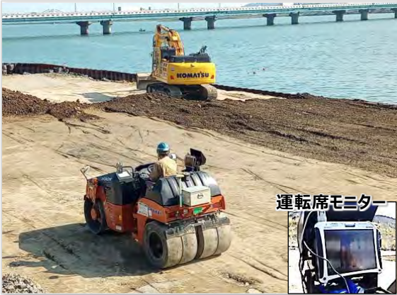
① ICT盛土（敷均・転圧）
