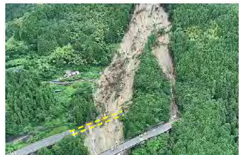
写真 2. 高速道路の土砂崩れ 高知自動車道大豊 IC～新宮 IC (上り) (高知県大豊町)
