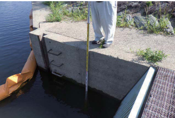
渇水時における取水施設の水位調査
