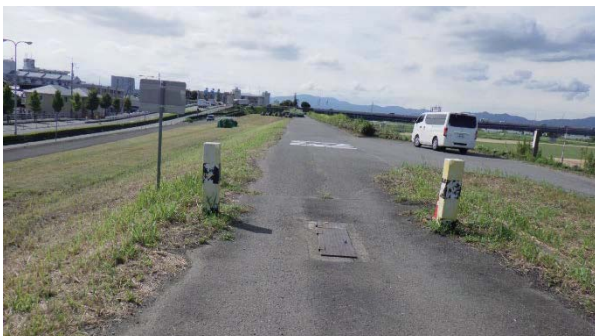
虎模様の規制杭（河川管理用の通路）
