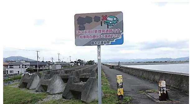
その横に一般車両の通行規制標識
