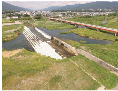
写真3-2.曾江谷川の床固工 (曾江谷橋下流)
