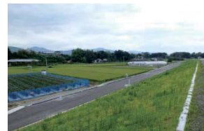
写真 4 堤防整備と併せ 市道を拡幅
