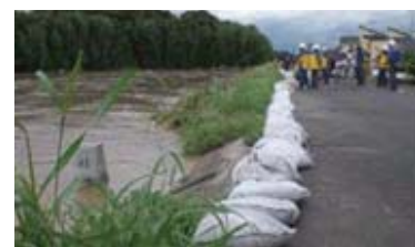
積み土のう工など 水防工法の実施
