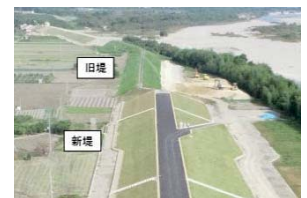
写真 8 築堤施工状況
