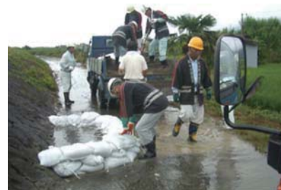
水防団による水防活動 (月輪工法)
