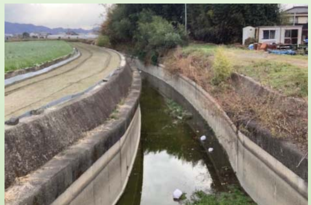
写真 3. 屈曲し狭隘な旧河道
