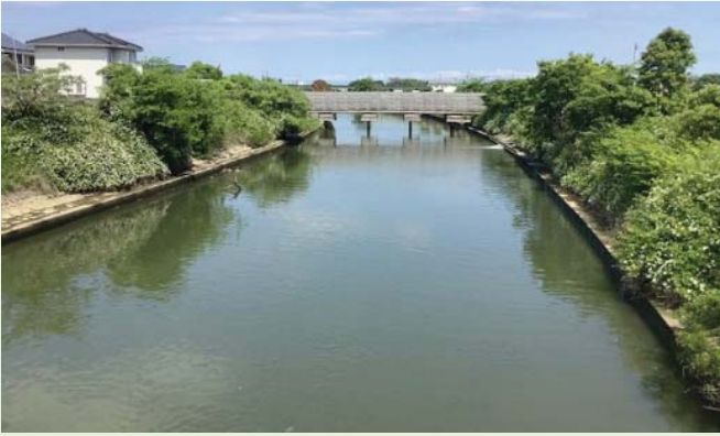
写真 1. 飯尾川第 1 樋門下流の新川開削河道
