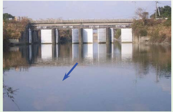
写真 2. 旧飯尾川第 2 樋門 (平成 23 年に改築)
