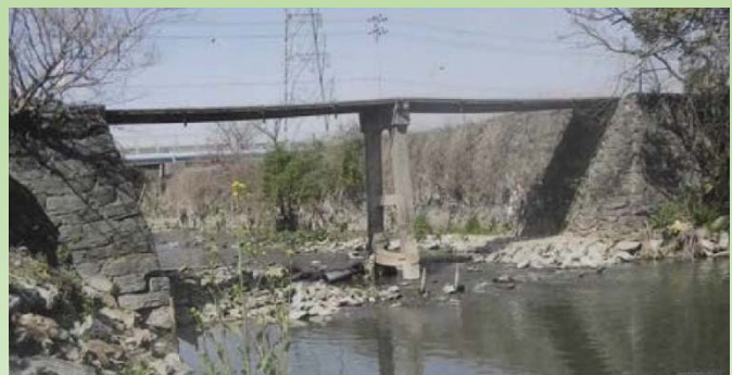
▶写真 4-2 加減堰下流端(平成24年)
