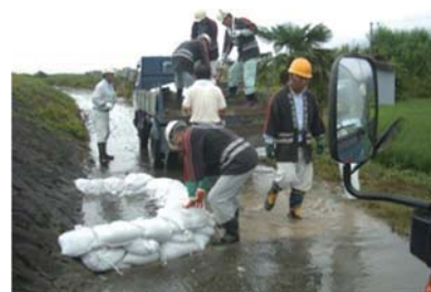
▲水防団による水防活動 (月輪工法)
