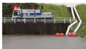
写真5.ポンプ車による排水状況
