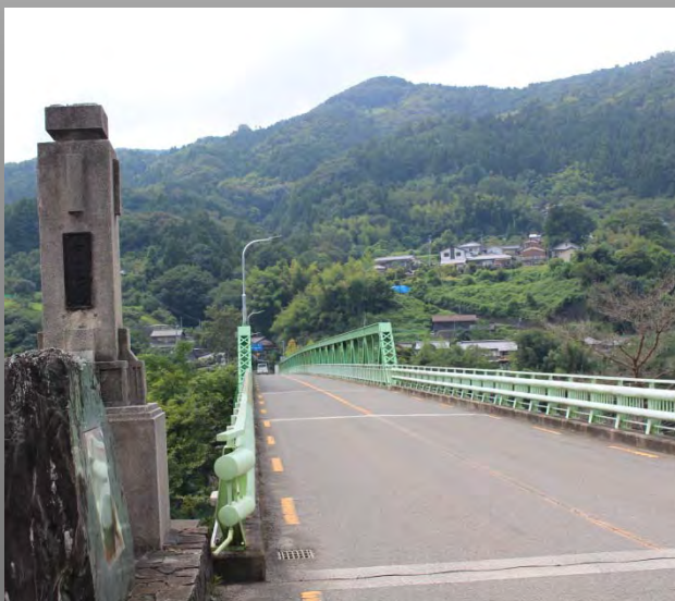
三好橋の東岸側には、昭和2年に架けられた吊橋の主ケーブルが今も残されています。
