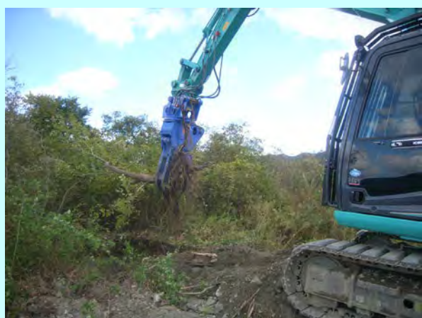
写真－７ 機械による樹木の引抜き
