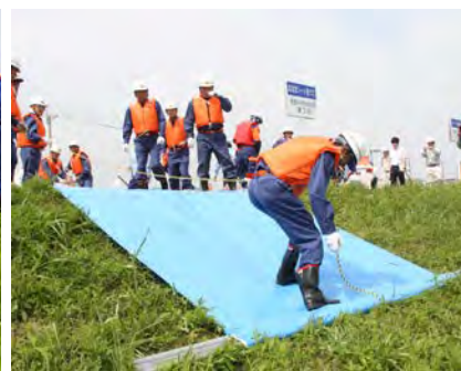
応急型シート張り工
