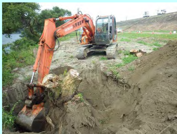
写真－８ 機械による除根
