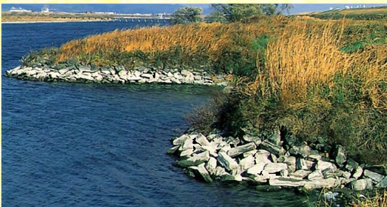
写真1: 水制工〔吉野川右岸(南岸)、覚円付近〕
