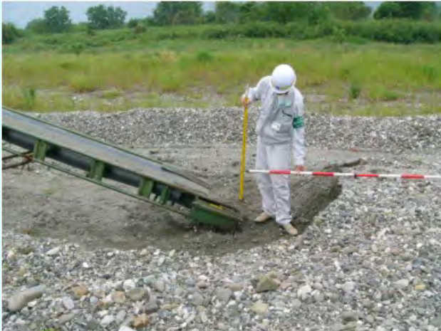
砂利採取状況の点検（掘削深さを確認）
