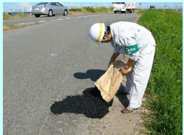
管理用道路点検（簡易な補修を実施）
