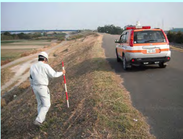
堤防調査（陥没等の異常の有無を確認）
