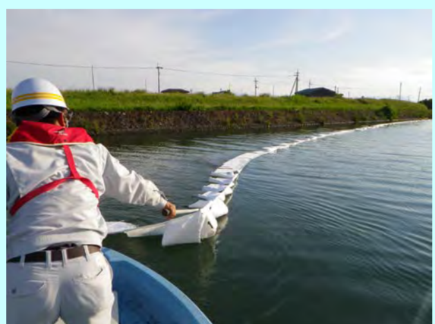
水質事故対応（吸着マットを設置）
