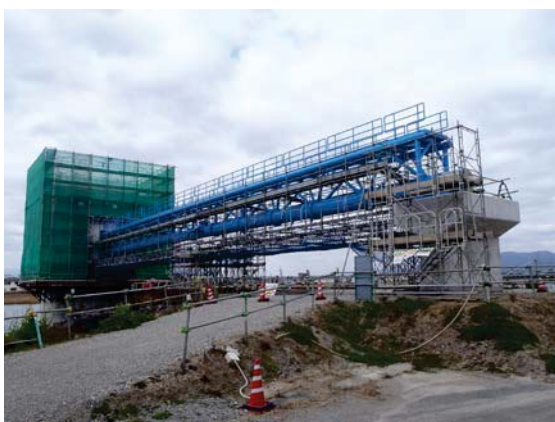
写真一 3 取水塔上屋と水管橋
