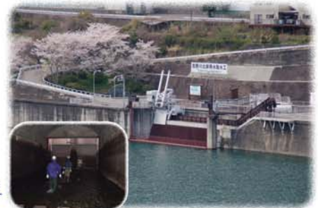
池田取水工。ここから安定した水量が供給されている。左下写真は、取水工付近のトンネル。どれだけ大きいのかよく分かる。 写真提供：吉野川北岸土地改良区
