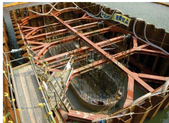
写真一 2 矢板締め切り
