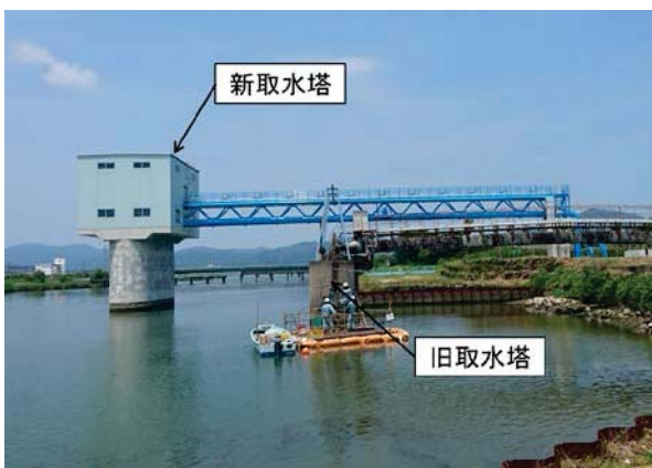
写真一 1 完成した新取水塔
