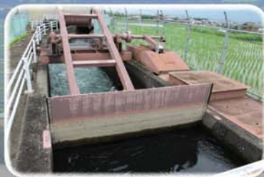
伊沢谷チェック工 手前の水位が高いのは調節をしているため。
