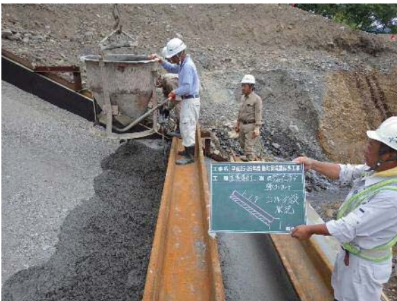
写真－3 護岸工（コンクリート張工）
