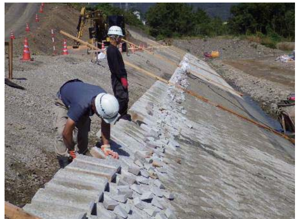
写真－4 護岸工（ブロック張工）
