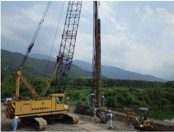
写真－1 止水矢板の打設
