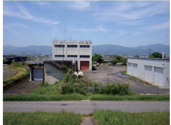
写真-2 排水機場
