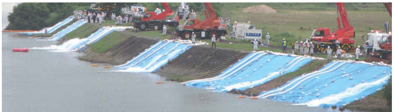
排水作業（全体）
