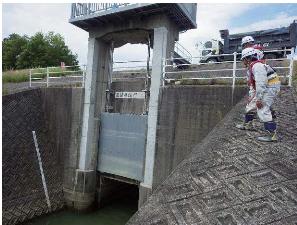
写真－７ 樋門点検状況
