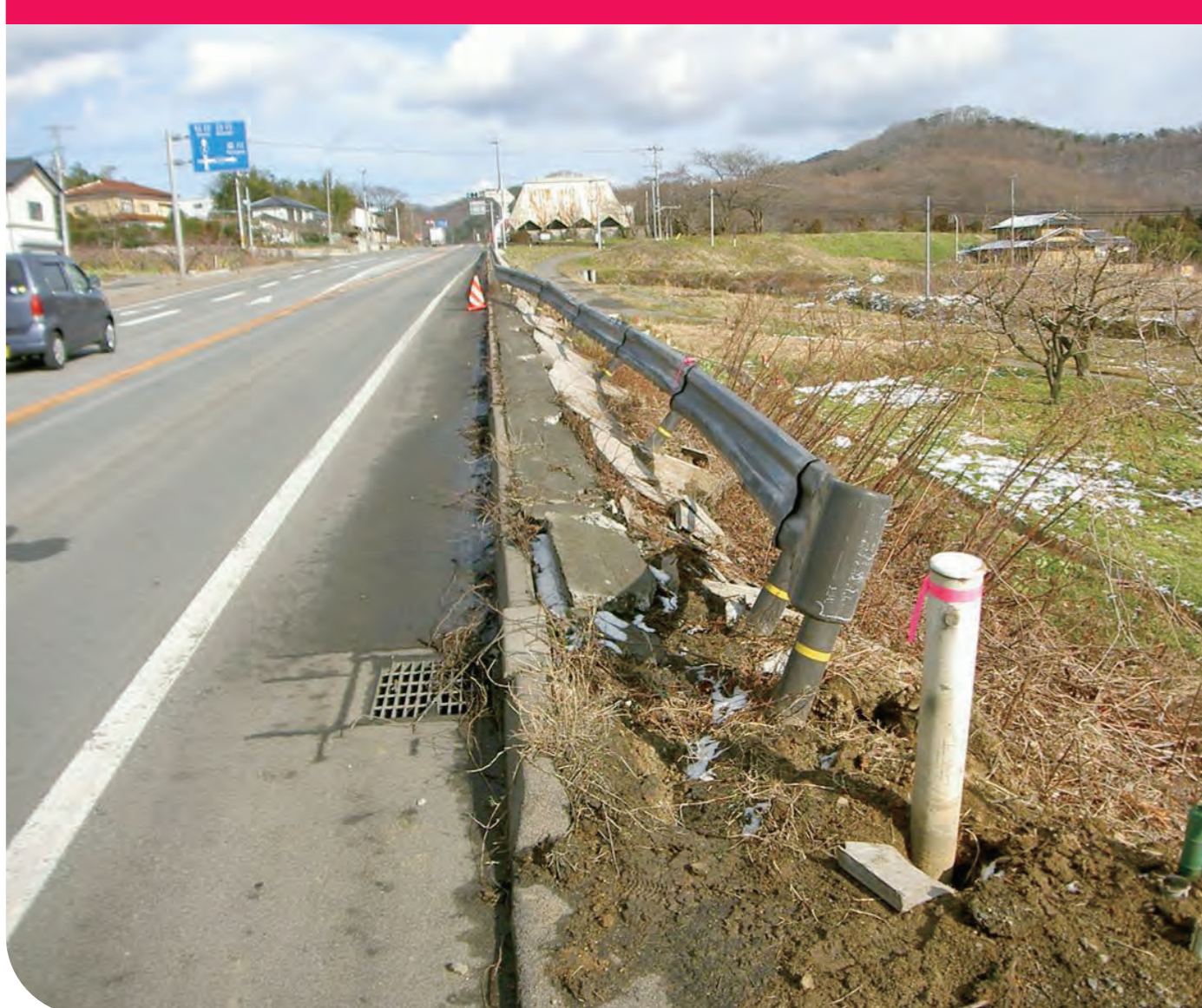
ガードレール・標識等の損傷
