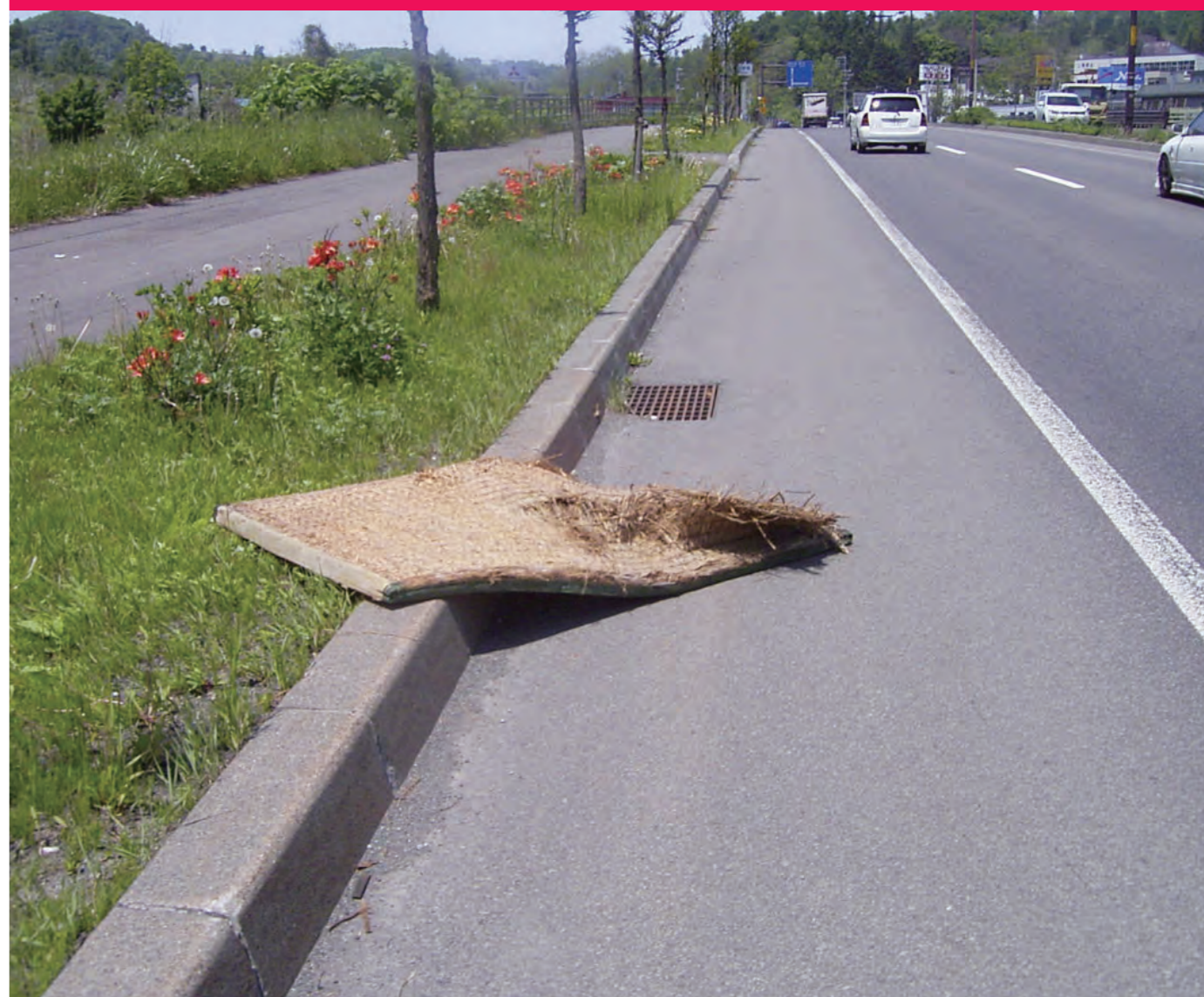
路面の落下物
