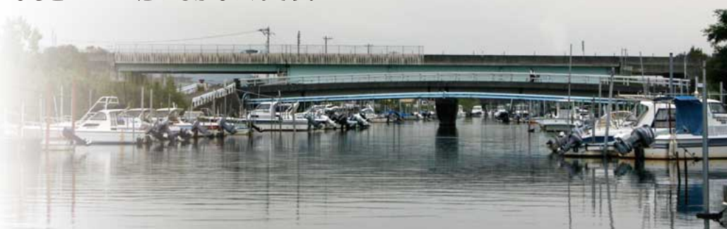
雄大な吉野川から榎瀬川樋門をくぐると景色ががらりと変わります
