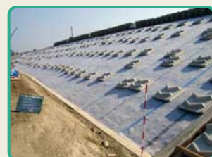
遮水シート設置状況
