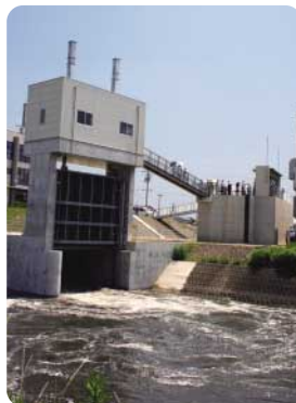
ポンプの試運転
