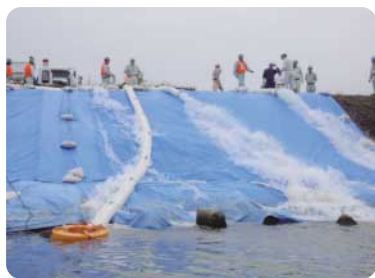
実際の内水被害発生時には堤防の居住地側の水が川へと排出される。
