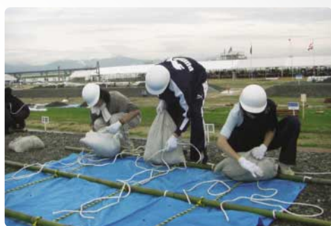
今回初めて、この水防演習に参加した徳島大学工学部 建設工学科3年生と2年生 42名。 川側の崩壊と漏水を防ぐため、堤防にシートを張るシート張り工を行っています。
