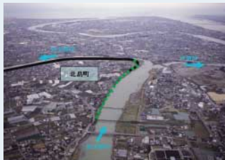
▲大麻箇所(新喜来上流地区) 【北島町高房地先】
