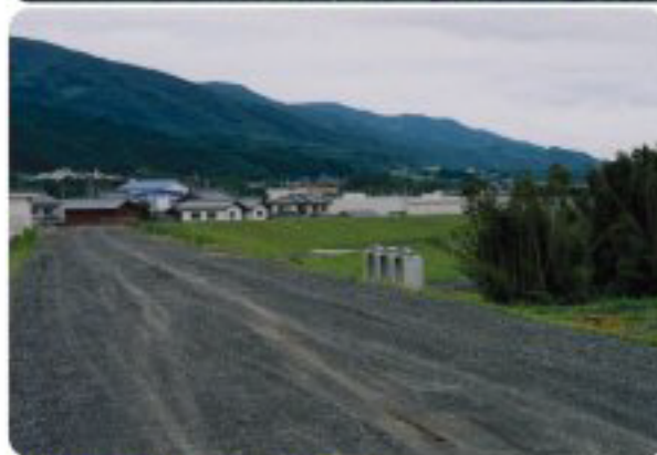
完成した堤防。長さは、3.4km。
