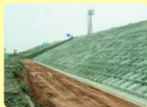
平成17年度 石井漏水対策工事（名西郡石井町藍畑）
