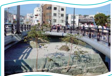
今も人柱伝説が残る福島橋の橋脚
