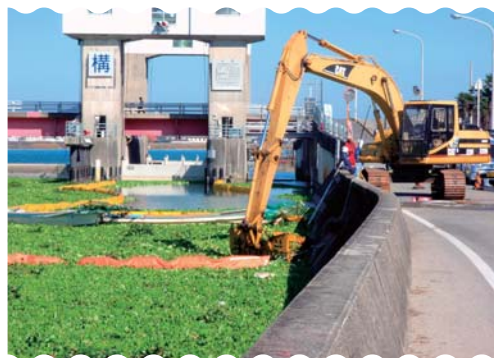
重機(バックホウ)による除去の様子
