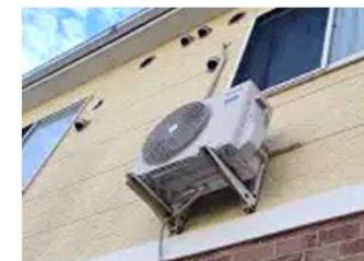
室外機の高所移設
