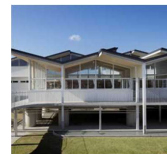
高床化による浸水対策
