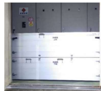
止水壁の設置
