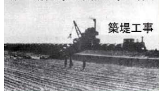
第一期吉野川改修工事の様子
