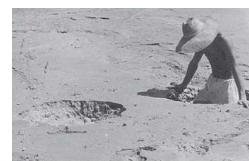
写真-1 漏水状況写真(明治29年台風12号)
