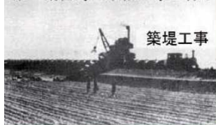
第一期吉野川改修工事の様子
