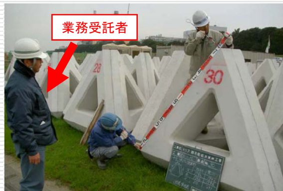
(根固めブロックの材料確認)
