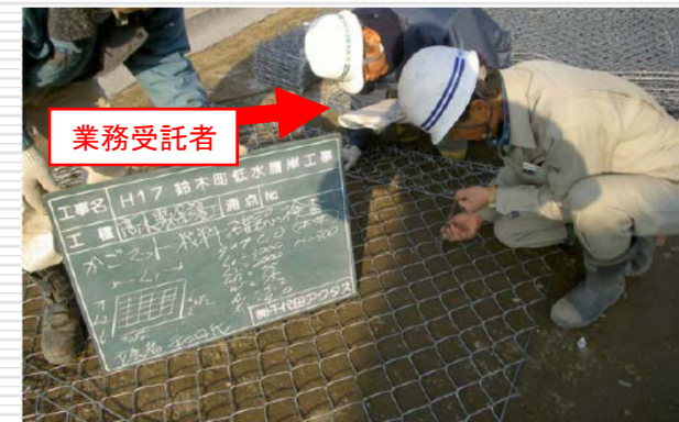
(河川護岸用かごマットの材料確認)
