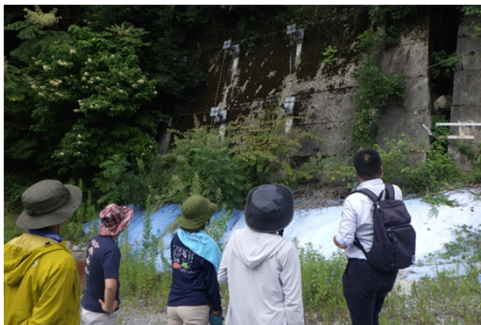
有瀬地すべり調査
