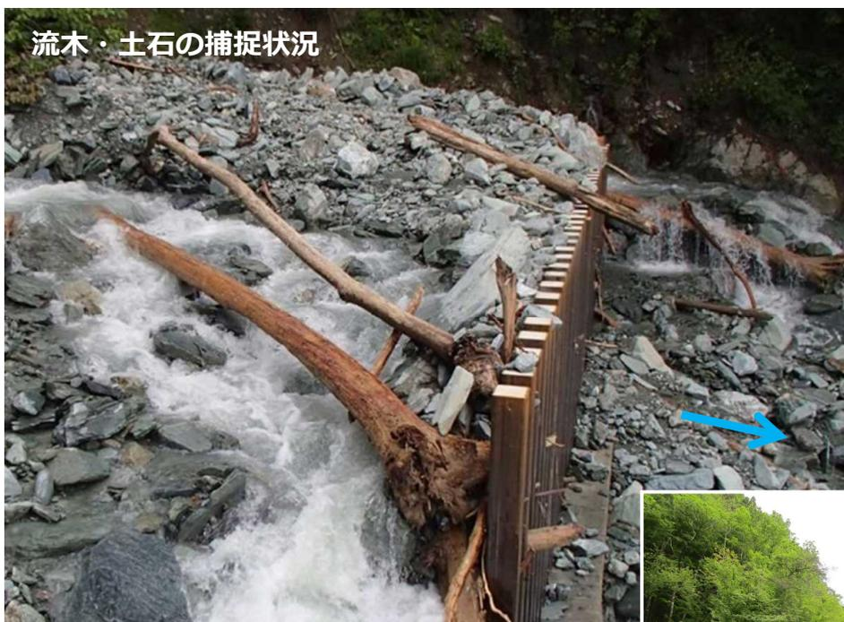
豪雨により上流域に堆砂していた流木・土石が流出したが、応急対策工がこれを食い止め、下流への被害を防止。
