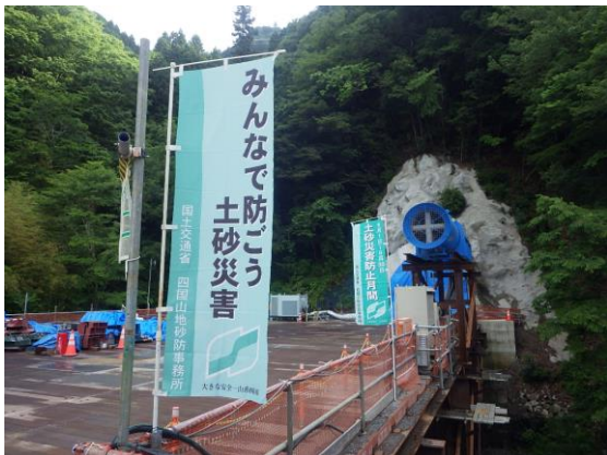
有瀬排水トンネル
