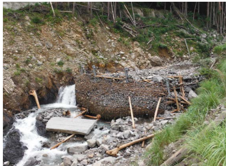
土石流の捕捉状況
