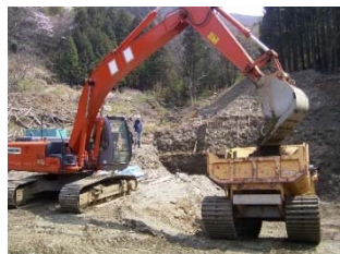
1.内部材の積み込み
