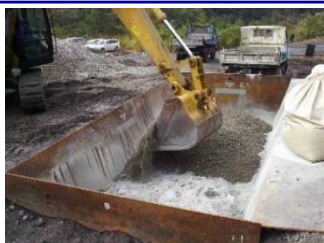
1.使用材料を混合枡へ投入
