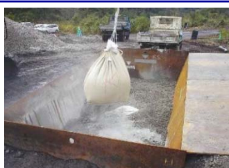
2.セメントを混合枡へ投入
