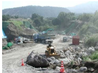
2.内部材の運搬
