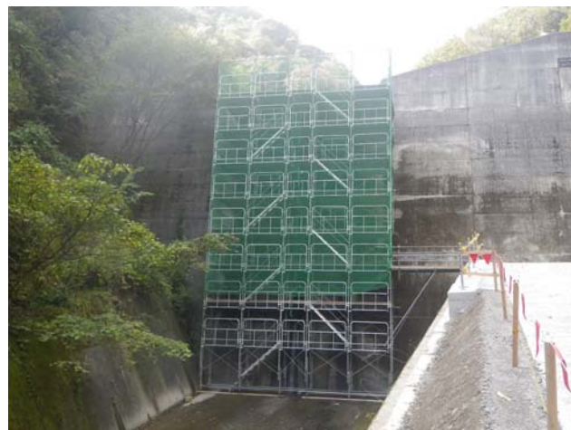
荒木谷堰堤改良工事
