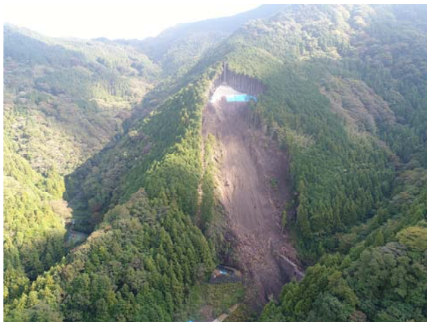
池ヶ谷法面对策工事
