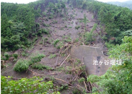
崩壊状況(H27.7.18撮影)
