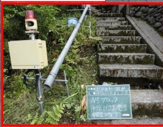
地盤伸縮計設置
