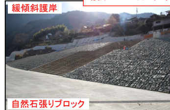
護岸工により洪水時の地山の浸食を防ぎます。
