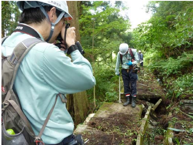
クラックの調査状況
