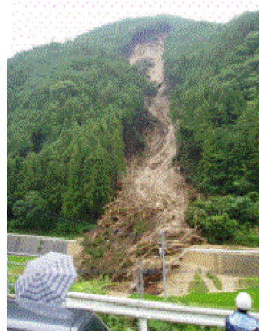
平成17年7月梅雨前線豪雨 砥部町（旧広田村）で発生した土砂災害
