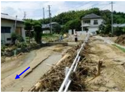
又野川（新居浜市）の被害状況（H16台風15号） 河川が土砂で埋塞
