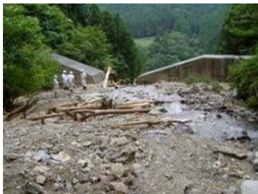
H16年台風16号・23号により土石流が発生 （上浮穴郡久万高原町） （写真は台風16号後、既設えん堤により土石流捕捉）
