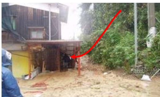
宇和島市のがけ崩れ発生状況（H16 台風 23 号）
