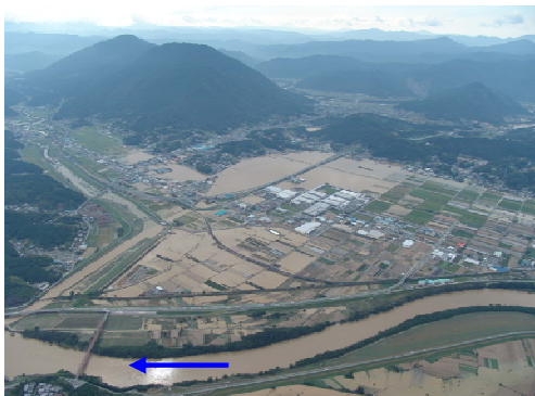
肱川（大洲市東大洲）の浸水被害（台風16号） 浸水面積約230ha、床上41戸、床下47戸
