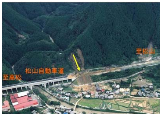
新居浜市大生院地区（台風21号） 地すべり性崩壊により人家2戸が全壊し4名が死亡
