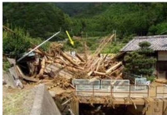
西予市吉信川（台風16号） 吉信川からの土石流により、人家一部損壊1戸の被害が発生
