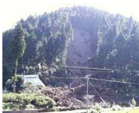
東温市（旧川内町）（台風21号） 土砂災害が発生
