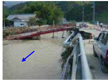
阿島川（新居浜市）の被害状況（H16台風21号） 流木により橋梁箇所が閉塞し、橋梁が崩落
