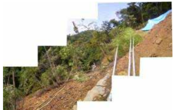
宇和島市高串の山腹崩壊(H18 7月梅雨前線豪雨)
