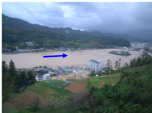
久米川（大洲市阿蘇～西大洲）の浸水被害（台風23号） コンビニエンスストアやマンションなどが浸水
