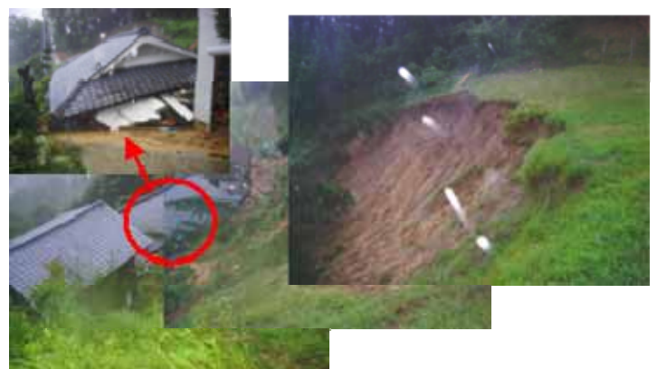
平成17年7月梅雨前線豪雨 大洲市(旧河辺村)で発生した土砂災害
