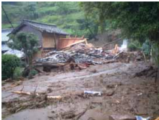
平成17年7月梅雨前線豪雨 伊予市（旧中山町）で発生した土砂災害
