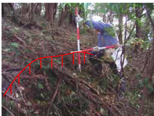
Fブロック頭部の段差地形
