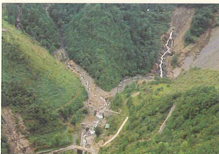
土石流を補足した朝谷第2えん堤 H16.8(高知県土佐郡大川村)
