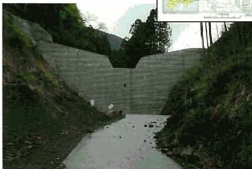
下流よりえん堤箇所を望む
