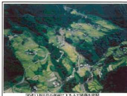
平成11年9月の豪雨による土石流発生状況
