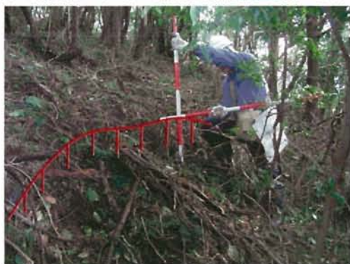
Fブロック頭部の段差地形
