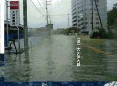
④ 県道大洲保内線浸水状況 (台風23号)
