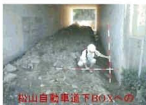
松山自動車道下BOXへの土砂流出状況
