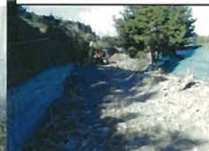
側道への土砂流出状況
