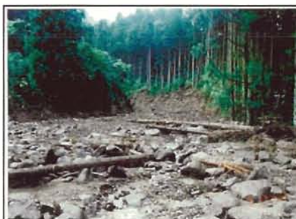
平成31年9月の豪雨による土石流発生状況
