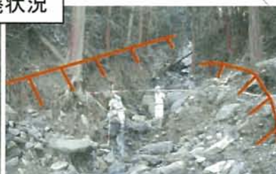
側道への土砂流出状況
