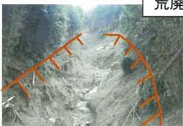
松山自動車道下BOXへの土砂流出状況
