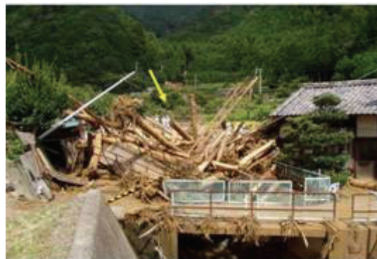
西予市吉信川（台風16号） 吉信川からの土石流により、人家一部損壊1戸の被害が発生
