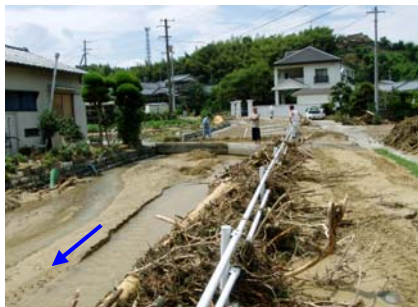
又野川（新居浜市）の被害状況（H16台風15号） 河川が土砂で埋塞
