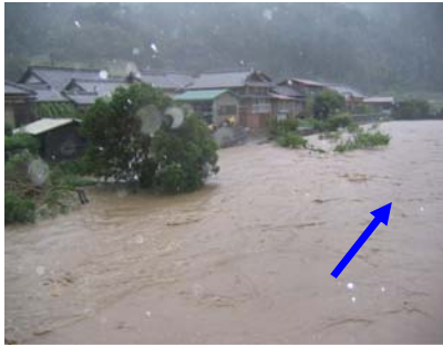
広見川（鬼北町）の状況（H16 台風 16 号） 増水により浸水被害が発生
