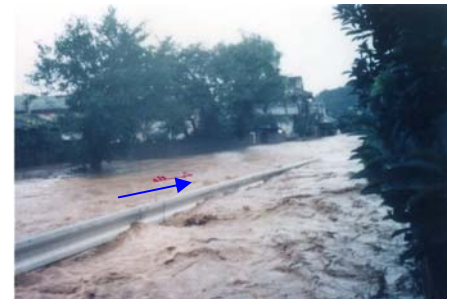
出海川（大洲市）の被害状況（H10台風10号）
