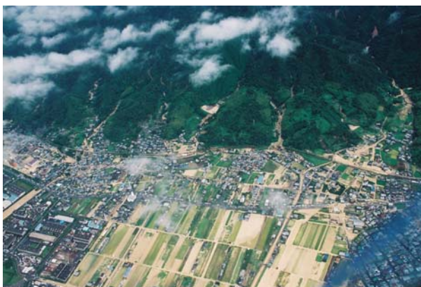
台風15号による土石流等発生状況（新居浜市多喜浜地区）
