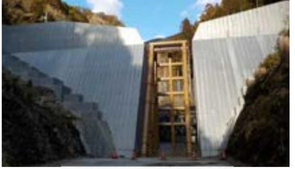
行川支川堰堤完了 (R4年3月)
