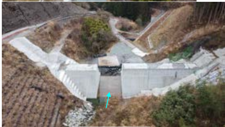
堰堤施工状況(R8年3月)
