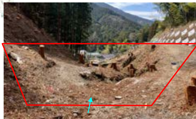
施工箇所(ほり谷砂防堰堤) (R8年3月)
