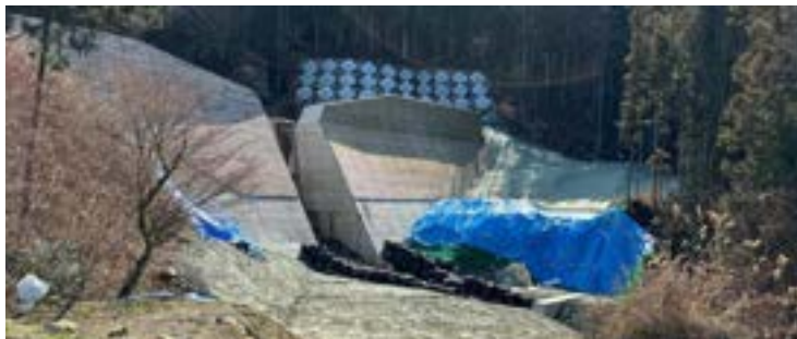
堰堤施工状況(R8年3月)
