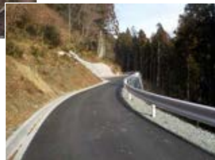
管理用道路施工状況(R7年2月)
