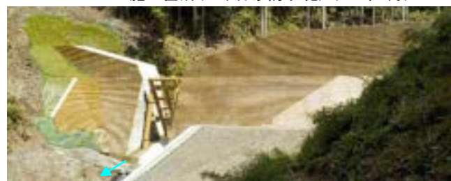
堰堤完成(谷奥谷砂防堰堤) (R5年7月)
