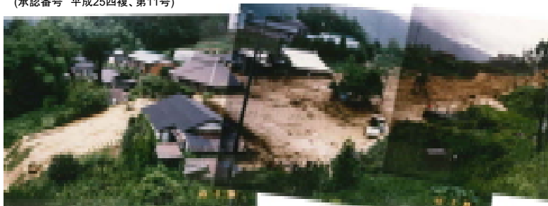
近隣の土砂災害状況(H5大豊町三津子野)
