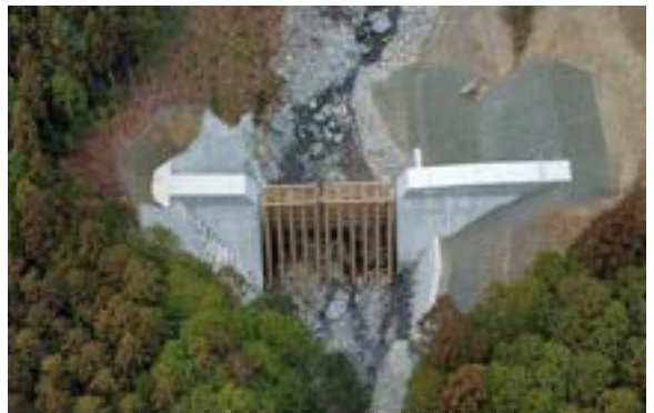
行川本川堰堤完成 (R7年1月)
