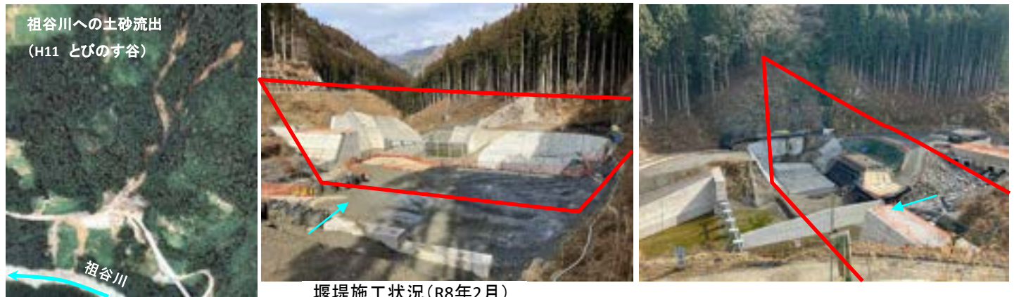
堰堤施工状況 (R8年2月)
