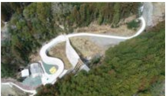
栗ノ木川支川堰堤完了 (R6年2月)
