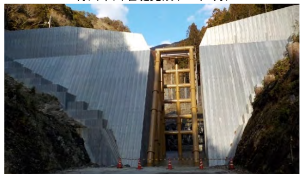
行川支川堰堤完了（R4年3月）
