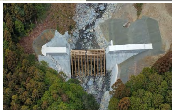
行川本川堰堤完成（R7年1月）
