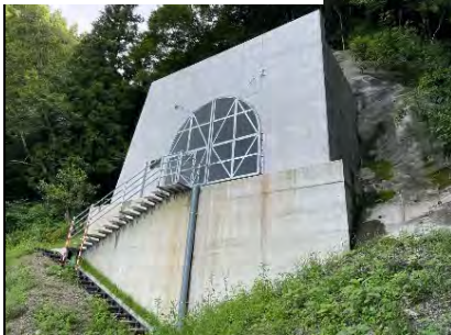
排水トンネル施工完了
