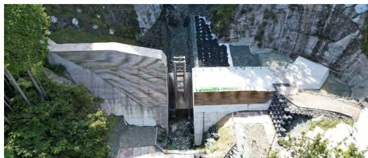
堰堤施工状況 (R7年2月)
