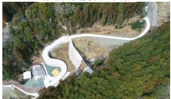
栗ノ木川支川堰堤完了（R6年2月）
