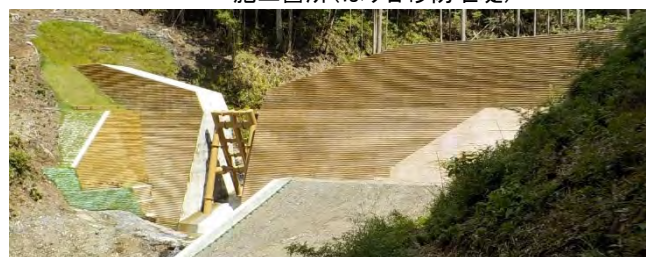
堰堤完成 (谷奥谷砂防堰堤) (R5年7月)
