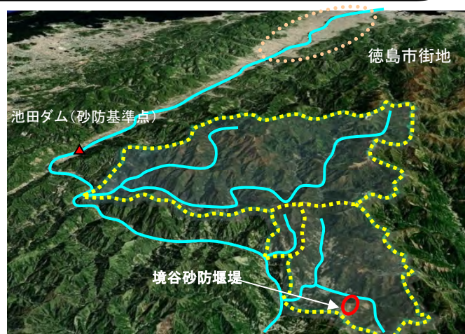
施工箇所全景
