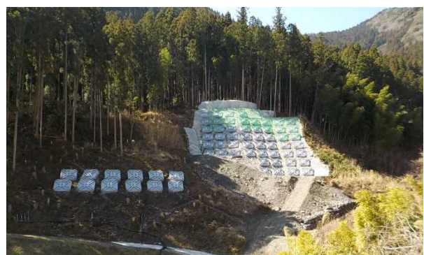
法面对策工(R6年3月)
