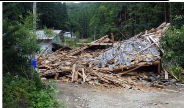
土石流による家屋の被災状況(栗ノ木川)
