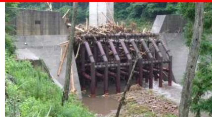
透過型砂防堰堤による流木捕捉事例
