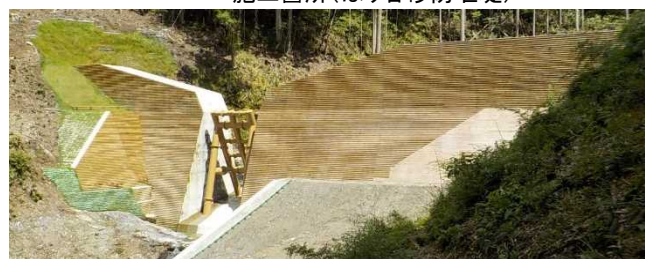
R5.7 堰堤完成 (谷奥谷砂防堰堤)
