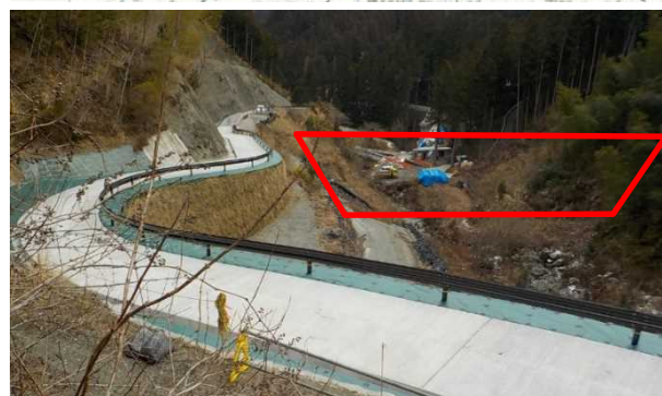
堰堤施工箇所
