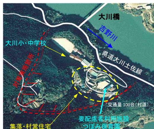
土砂災害状況(H16)
