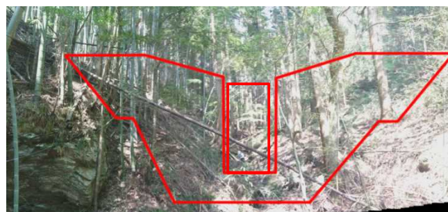
施工箇所 (ほり谷砂防堰堤)
