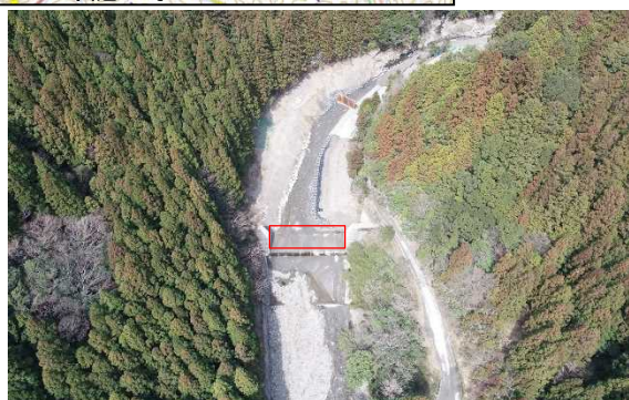
川奥谷堰堤改良施工状況(R6年3月)
