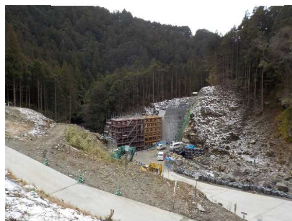
行川本川堰堤施工状況(R6年3月)
