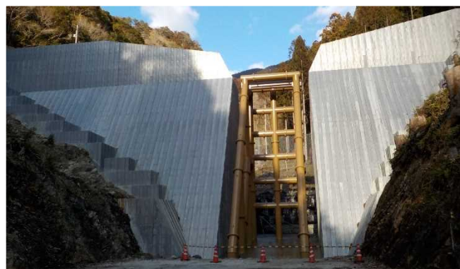
行川支川堰堤完了(R4年3月)
