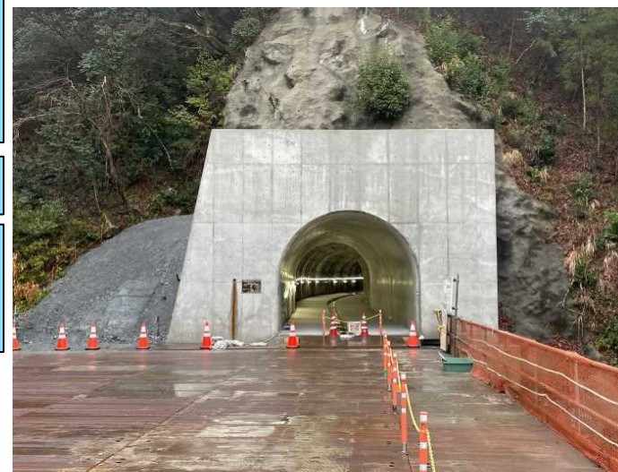
排水トンネル 坑口付近
