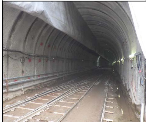
排水トンネル工
